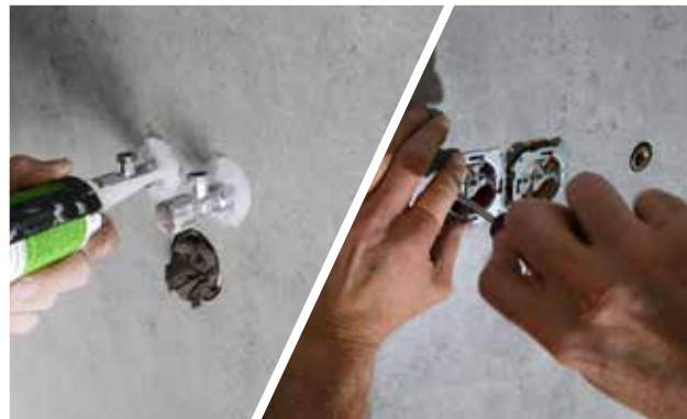
16. ÖFFNUNGEN MIT SILIKON AUSSPRITZEN UND ARMATUREN MONTIEREN
