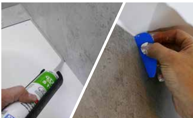
17. FUGEN MIT SILIKON ABDICHTEN UND SILIKON ABZIEHEN
