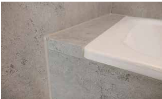
15. V-FUGEN-BIEGETECHNIK So ergeben sich geschlossene, saubere Außenkanten.
